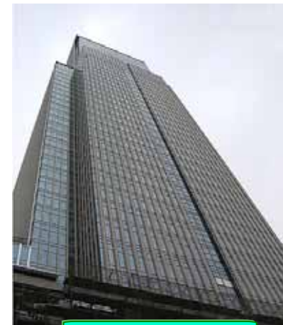
日本橋三井タワー
